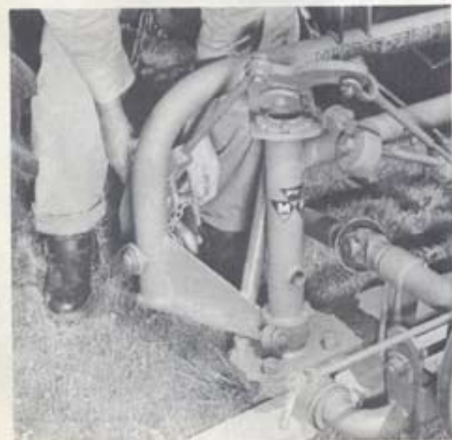
Fig. 43 Detaching Left Link
